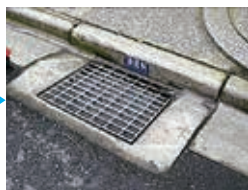
きれいな状態の雨水ます
